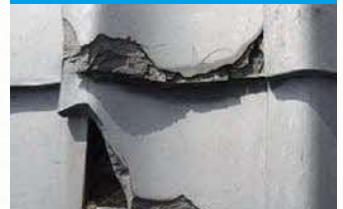
瓦が著しく破損している例
