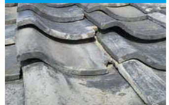
瓦が著しく破損している例
