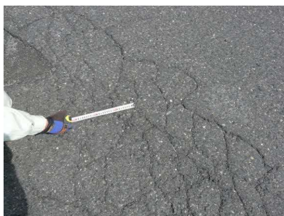
舗装のひびわれ状況
