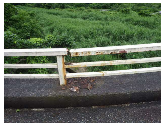
防護柵の破断状況
