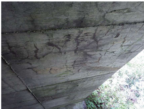
床版下面のひびわれ状況
