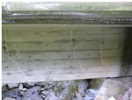
主桁のひびわれ状況
