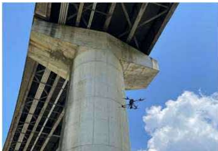
ドローンによる点検
