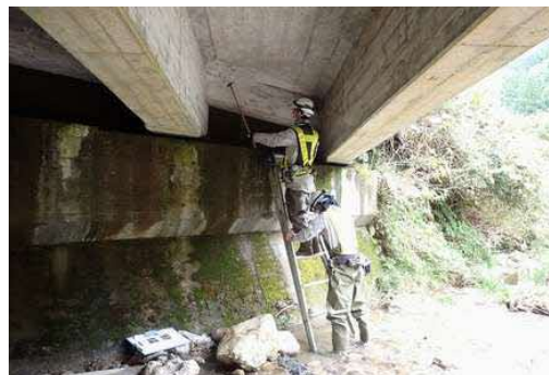
<ハシゴ等による点検実施状況>
