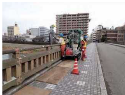
橋梁点検支援ロボットによる点検
