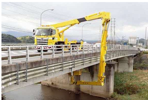
<橋梁点検車による点検実施状況>
