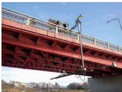
橋梁点検支援ロボットによる点検
