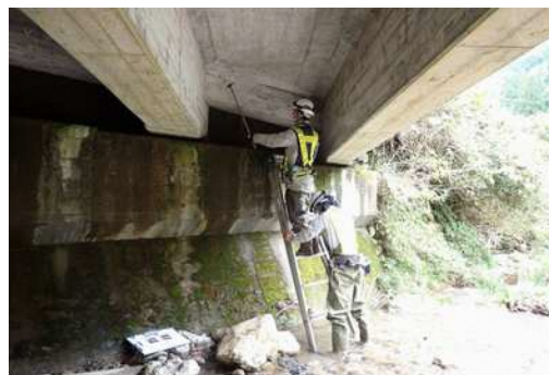
＜ハシゴ等による点検実施状況＞
