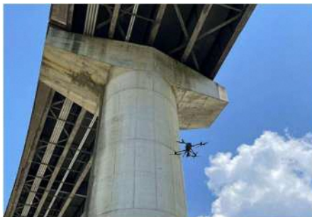
ドローンによる点検
