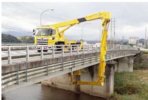
＜橋梁点検車による点検実施状況＞
