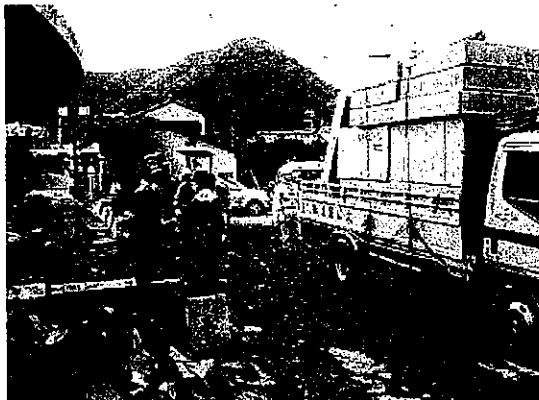
<仮設トイレ（組立前）の配送> 梱包された状態で設置予定地まで搬送し、現地で組み立てる。
