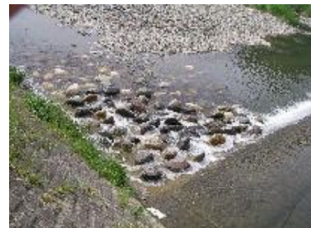
千代川永野堰に設置した簡易魚道
