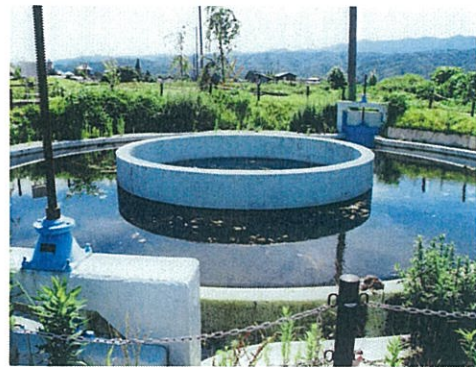
円筒分土工 (倉吉市関金町)
