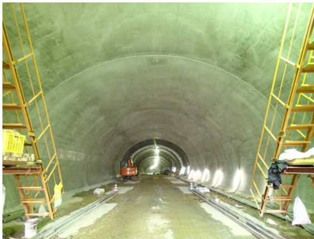
覆工コンクリートが完了した部分の状況です。現在40m区間完了しています。
