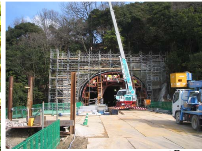
岩倉側では出入り口部の壁(坑門)を作る工事に着手しました。
