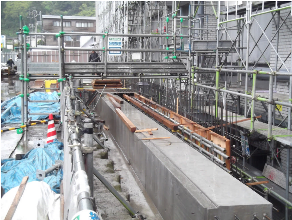
④ 北側ドライエリア型枠組立
