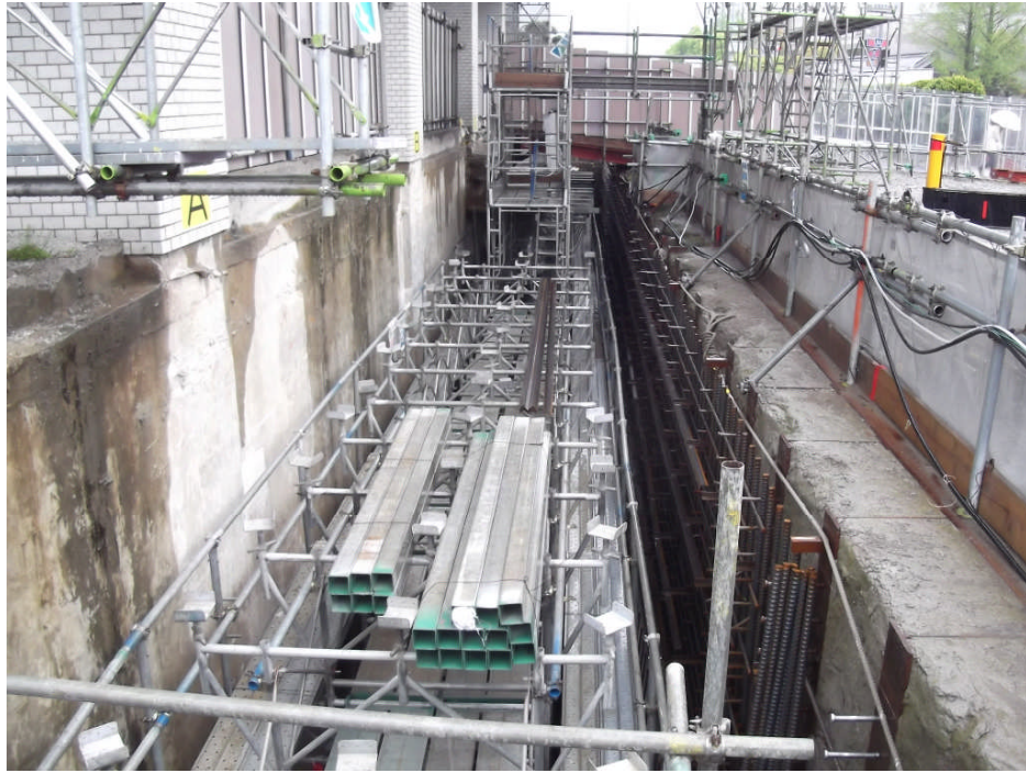
③ 西側擁壁支保工組み
