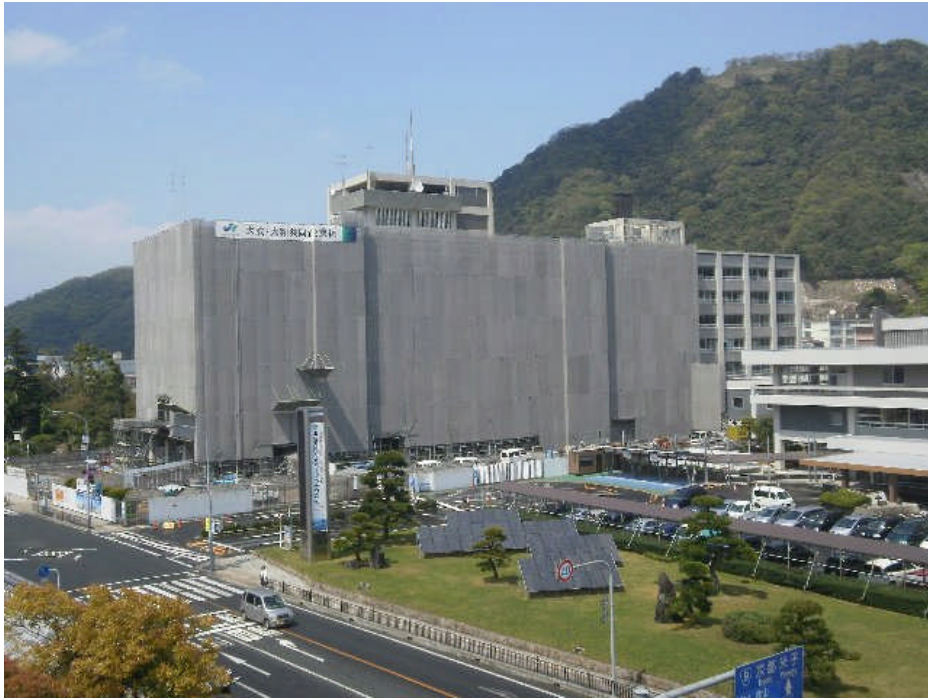
本庁舎（南面より）
