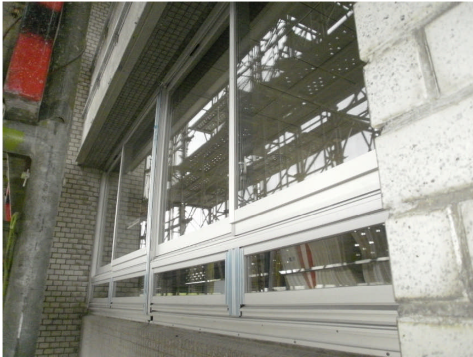
⑤ 本庁舎サッシ取り替え(外部)
