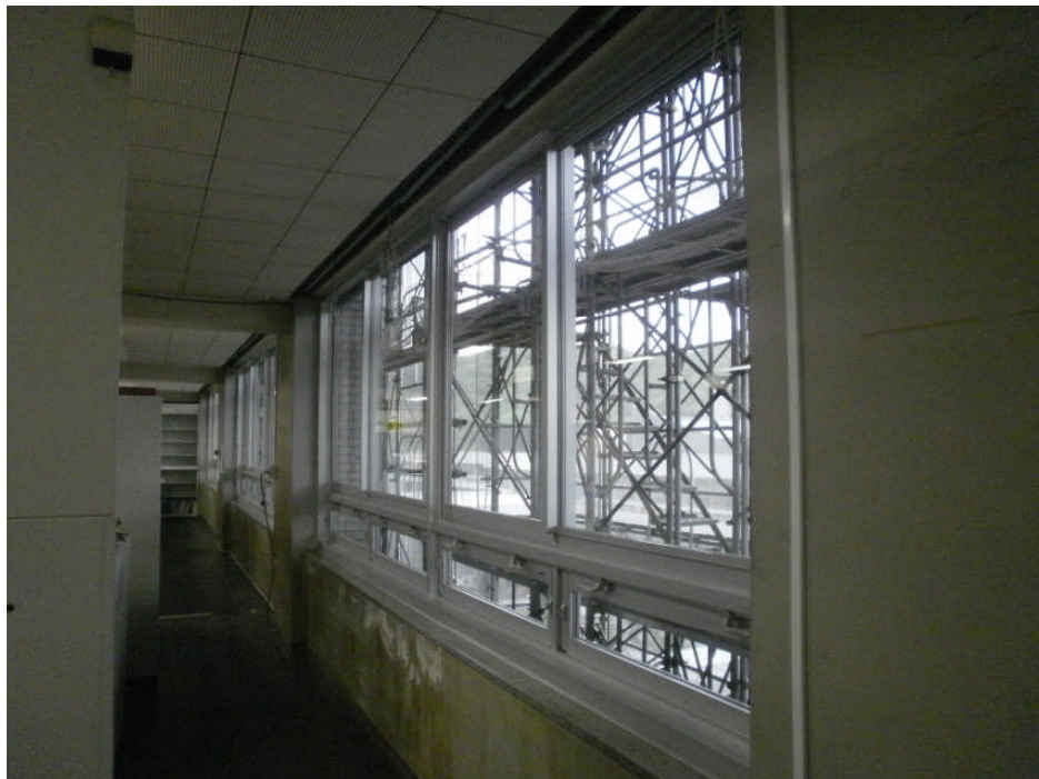
⑥ 本庁舎サッシ取り替え(内部)
