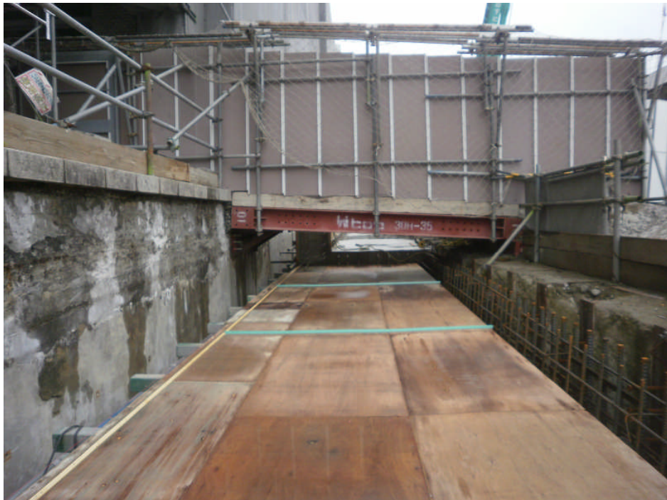
④ 西側擁壁 2 段目打設前
