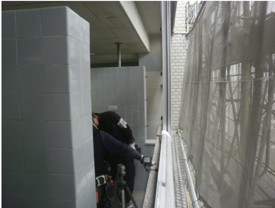
⑤ 本庁舎北面サッシ取り替え(内部)
