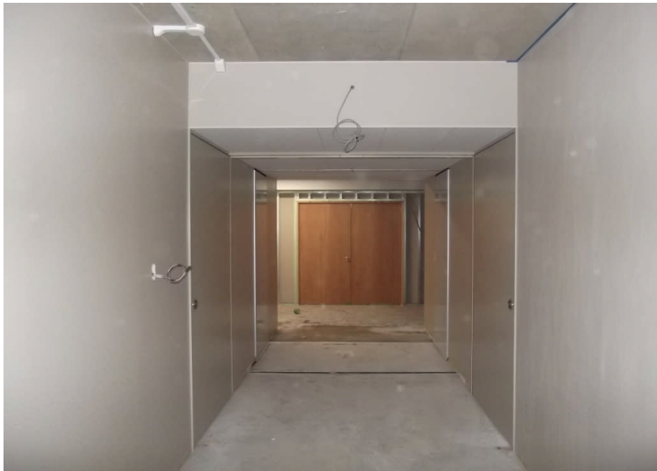
② 西側地下連絡通路仕上状況
