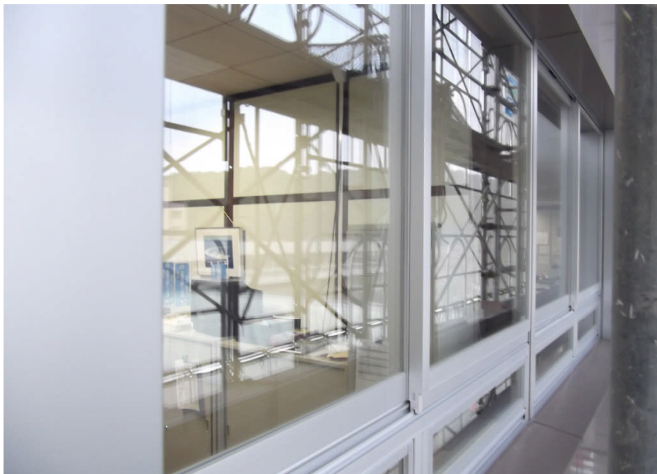
⑥ 本庁舎南面サッシ・パネル施工完了
