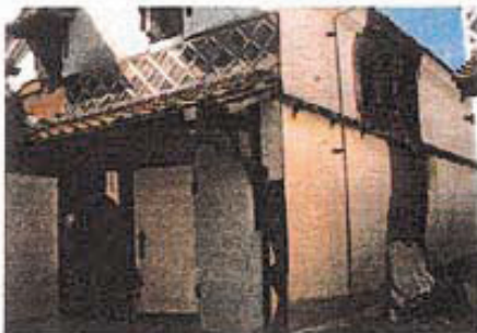
国指定重要文化財である後藤家住宅も、蔵の壁が剥落したり、土壁が倒壊するなどの被害を受けました。(米子市)
