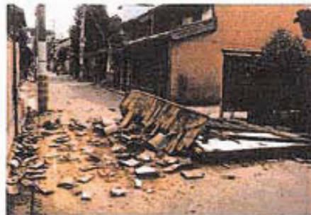
国指定重要文化財である後藤家住宅も、蔵の壁が剥落したり、土壁が倒壊するなどの被害を受けました。(米子市)
