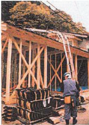
住宅の新築(日野町)
