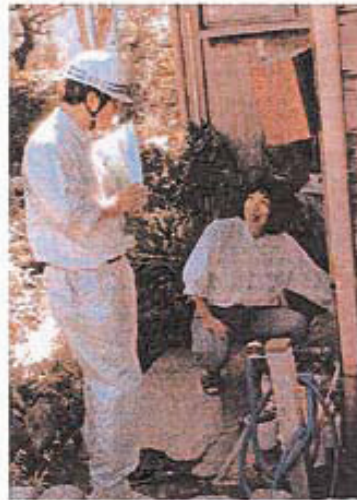
倒壊した家屋の応急危険度判定に 建築士ボランティアが活躍しました。 (日野町) (山陰中央新報社提供)
