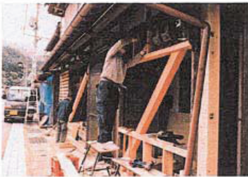
住宅の修繕(日野町)
