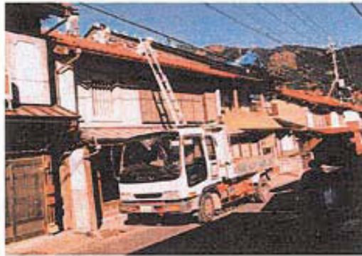
屋根の修繕(日野町)
