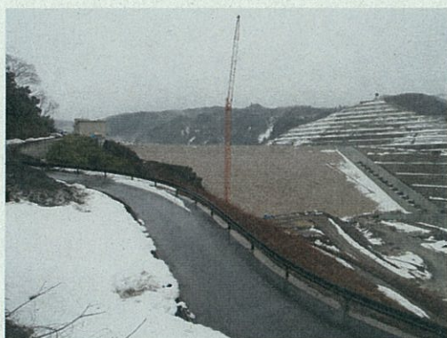
殿ダム（試験湛水中）
