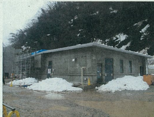
袋川発電所（建設中）
