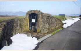
溶岩トンネル「竜溪洞」
