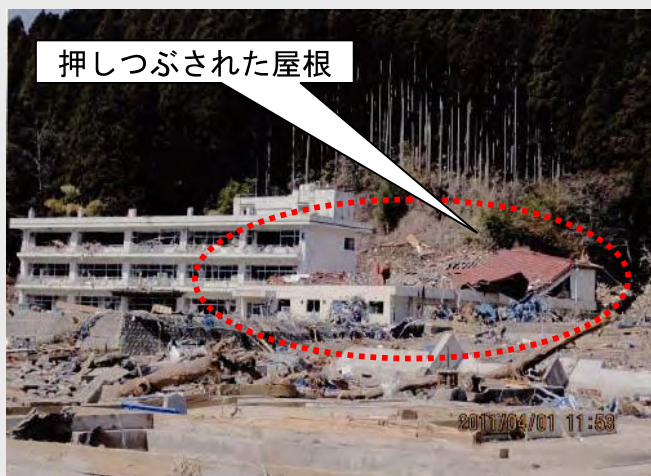
大破した屋内運動場
