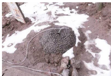
写真2 水琴窟上部(注水設備未完)
