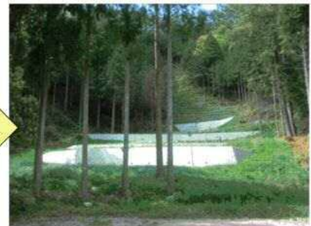
崩壊地の復旧を図るため、山腹工を実施し、森林の機能回復を図った。
