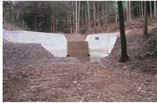
治山ダム施工により土砂の流出及び溪岸の浸食防止が図られた。
