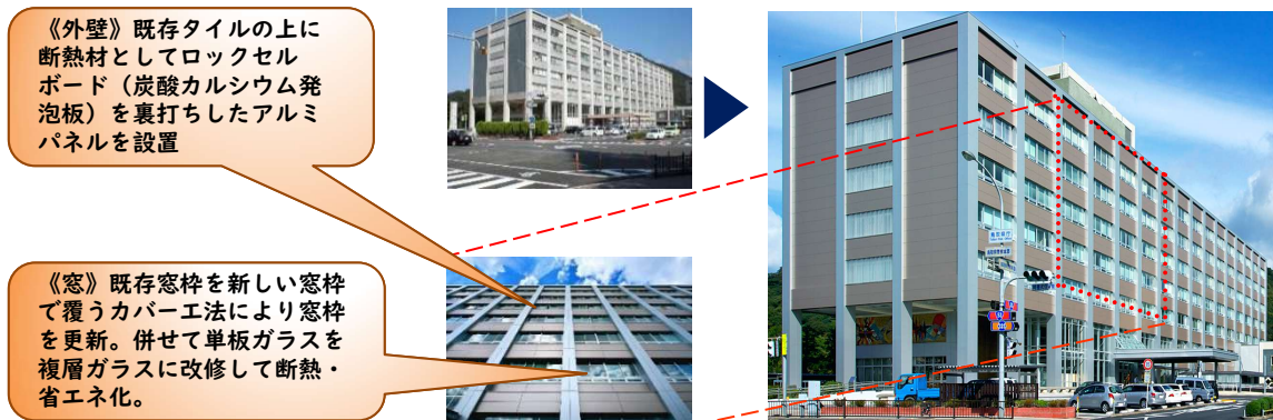
＜図1-4＞ 外壁・建具改修時の断熱化の例
