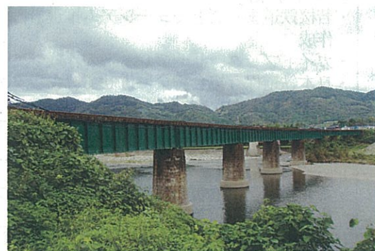
第一八東川橋梁
