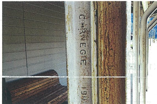
丹比駅の底に利用されている輸入レール [CARNEGIE（カーネギー）1911の刻印]
