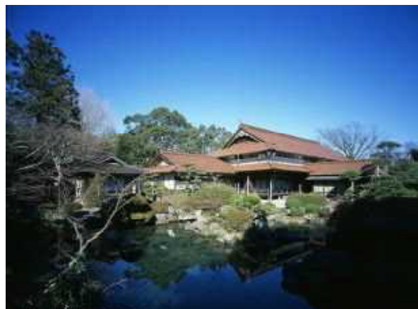
庭園から主屋、離れをみる
