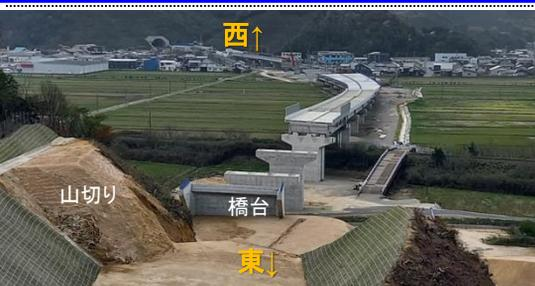
浦富高架橋のうち、浦富IC付近と同様にまだ橋桁が架かっていない東側では、現在、工場にて橋桁を製作中であり、夏頃から工場で作成した橋桁を運び込み、東側から橋桁を送り出し架設作業が始まる予定です（左写真参照）。
