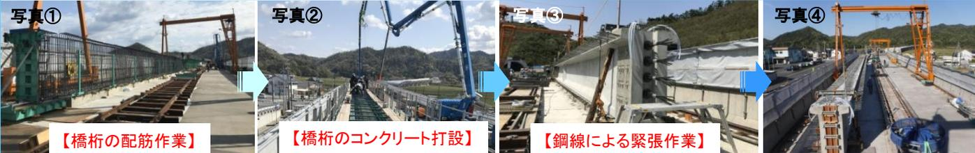
浦富IC付近での橋桁を架ける工事は、現場条件等から現地で橋桁を製作（写真①～④）し、製作した橋桁は西側から順に送り出して橋脚に架ける方法（写真⑤～⑧）を採用しています。
