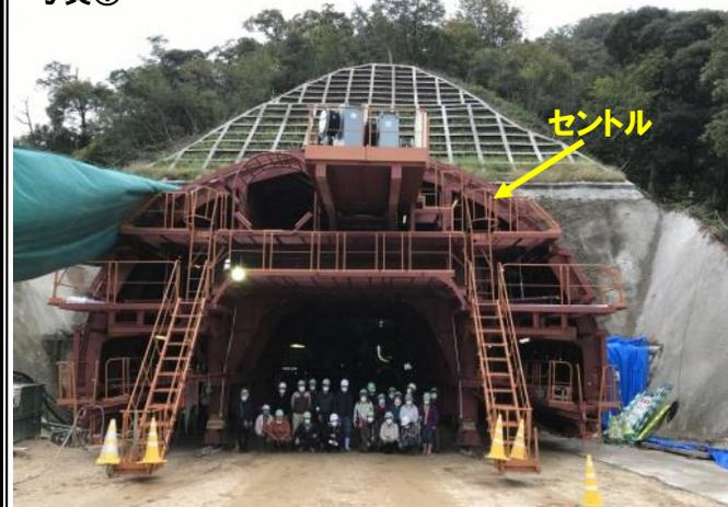
年内の貫通に向けて順調にトンネル掘削が進む牧谷トンネルでは、現在、延長412mのうち350m程度掘削が進んでおり、起点側では防水シート施工も始まっています。
