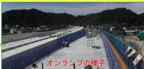
浦富高架橋では、橋桁の温度変化等による伸び縮みを吸収して、車の快適な走行を確保するため、橋桁と橋桁とのつなぎ目に取り付ける伸縮装置の施工が進んでいます。
