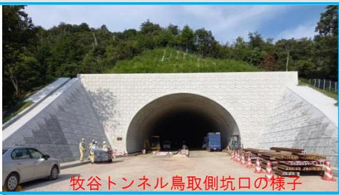
牧谷トンネルでは、中央分離帯のガードレール基礎や両側の円形水路がほぼ完成しました。現在は、コンクリート舗装の路盤工事が順調に進んでおり、9月末にはコンクリート舗装が完成する予定です。
