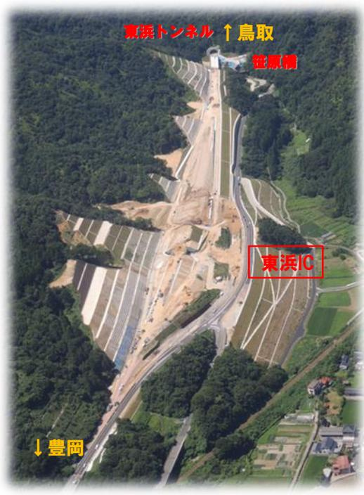
多くの工事が調整しながら進む東浜トンネル～東浜IC区間では、盛土工事や法面工事が進み、徐々に岩美道路の完成形がイメージできるようになってきました。
