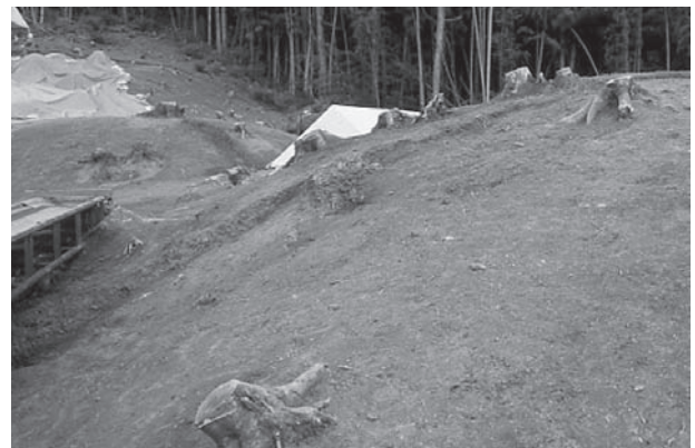
5. 23号墳北側流土堆積状況(北西から)
