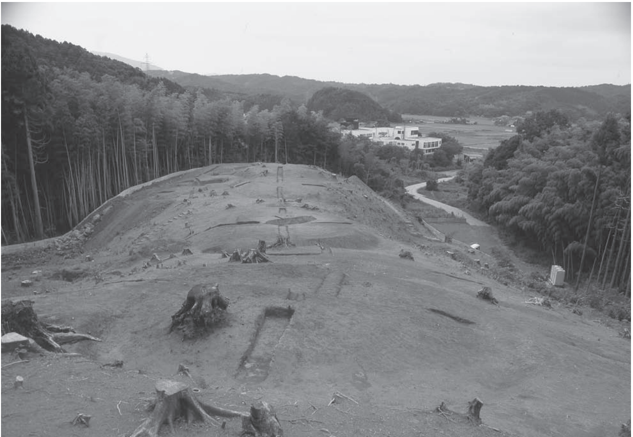
2. 盛土除去後全景(東から)
