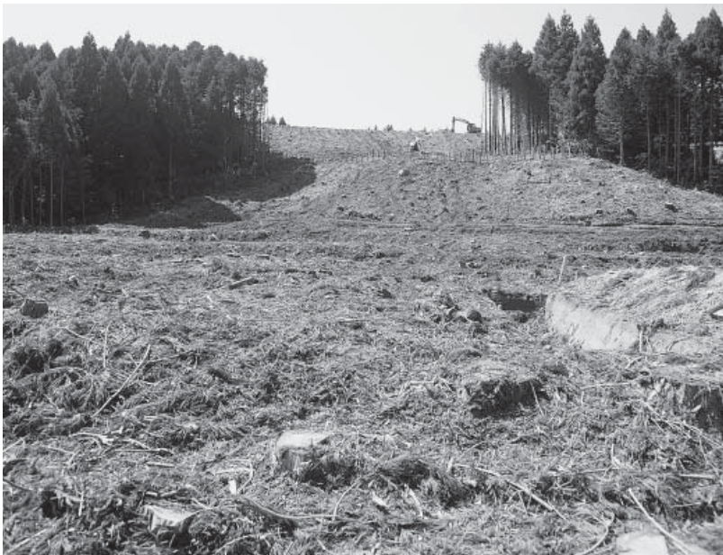
2 調査前の地形：1区谷部 (東から)
