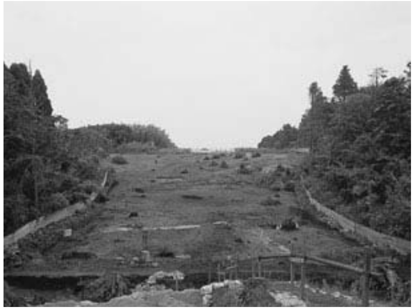
1 調査地完掘(東から)
