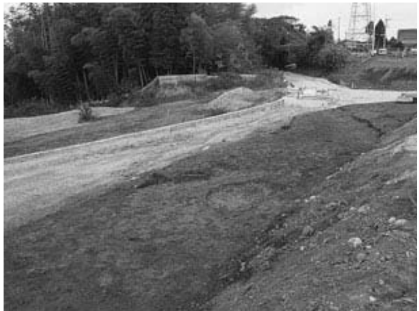
2 調査地完掘状況(南東から)
