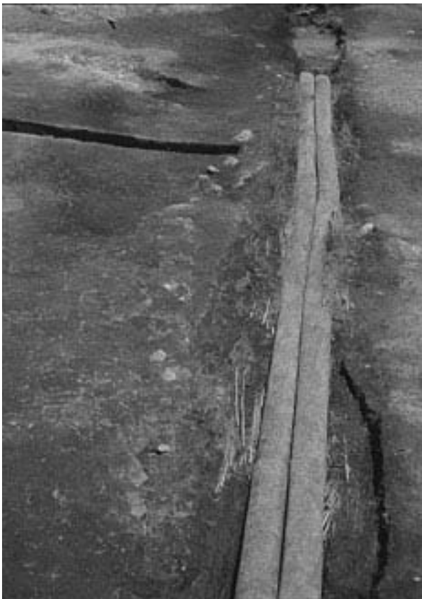
3 SD4検出(南西から)
