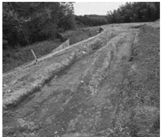
4 調査地完掘状況(南東から)
