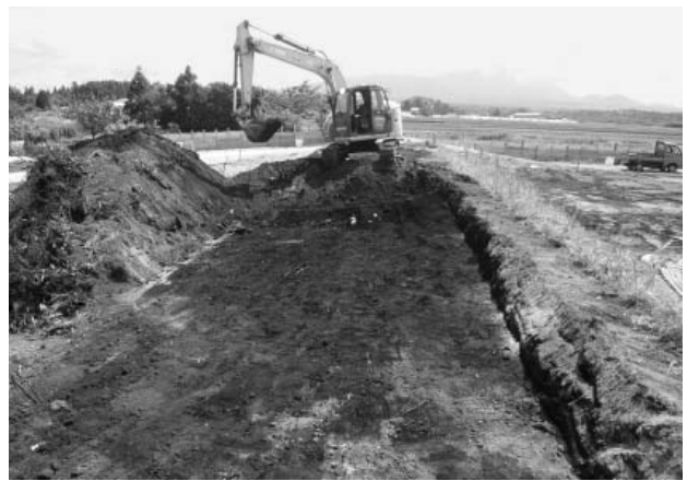
文中写真2 道路下重機表土剥ぎ作業
