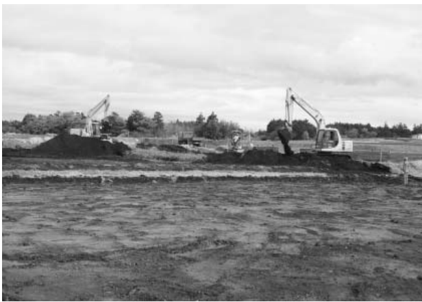
文中写真1 重機表土剥ぎ作業
