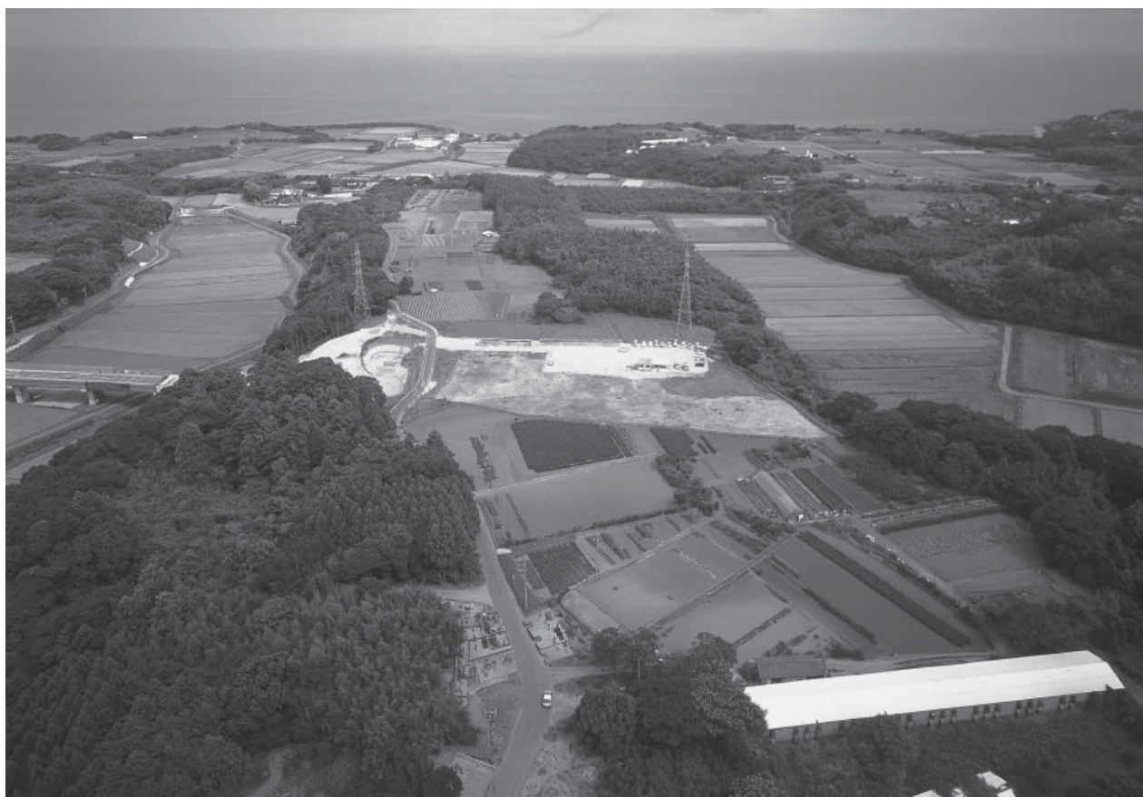
1 調査地全景(4区完掘：南から)
