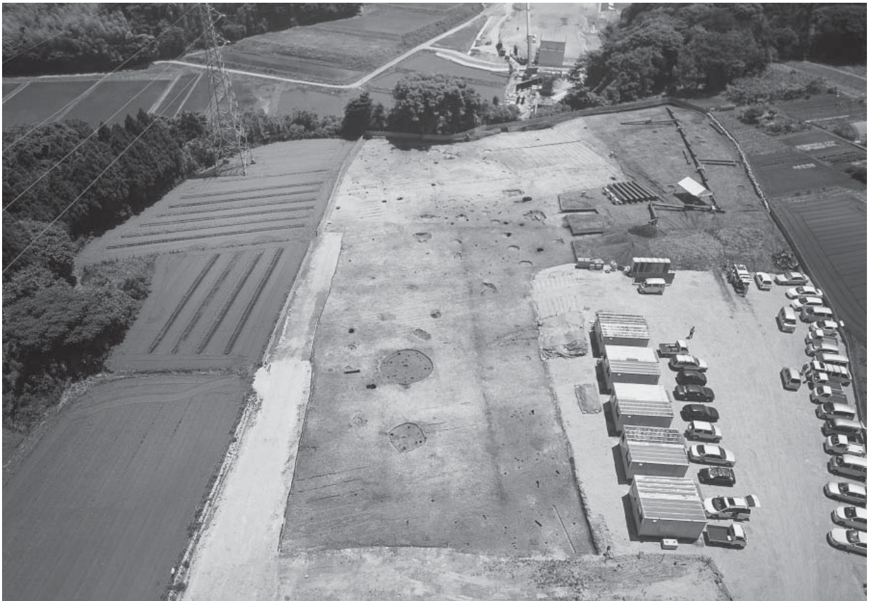
2 2・3区完掘(西から)
