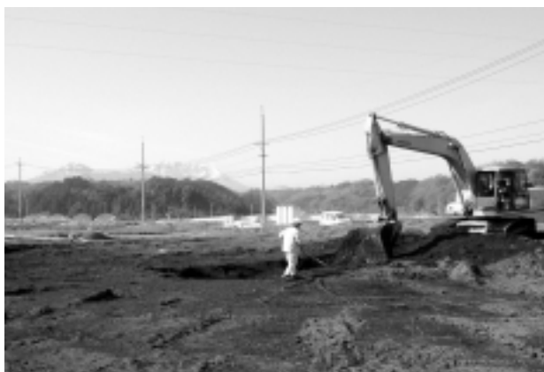
写真1 2区表土除去作業風景
