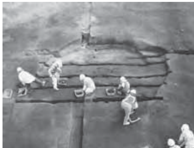
文中写真8 平成22年度2区作業風景(2)
