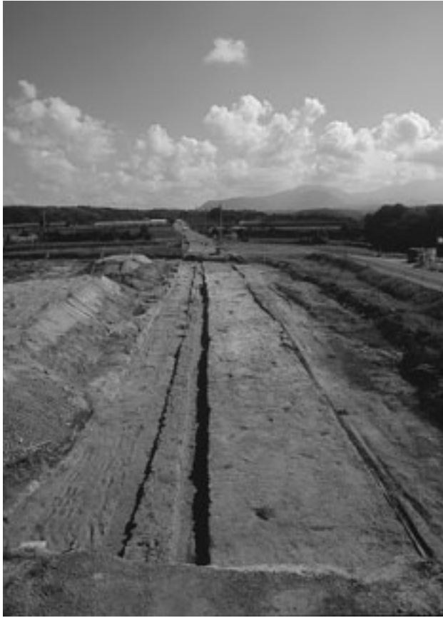
1 1区道路下完掘状況(北から)
