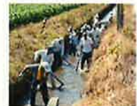
水路の泥上げ
