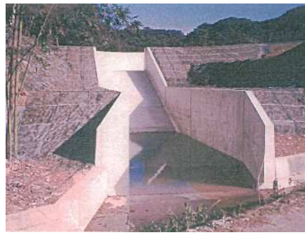
《漏水、破損、土羽の洗掘の有無》
