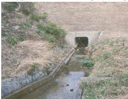
《詰まり、破損、土羽の洗掘の有無》
