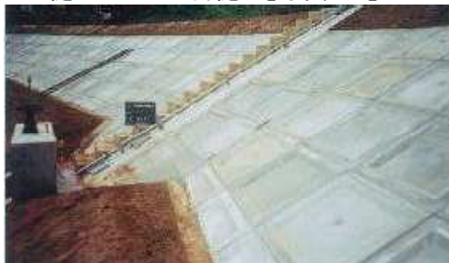
《ゲートの稼働不良や護岸の亀裂等の有無》
