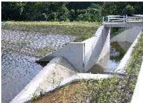
《堰上げ、ごみ、不等沈下、破損の有無》
