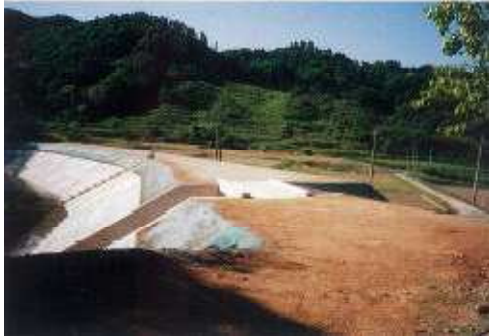
《堤体の草刈りや沈下の有無》
