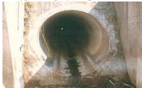
《漏水、不等沈下、破損の有無》
