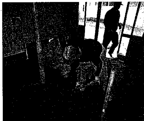
<玄関の泥出し>
