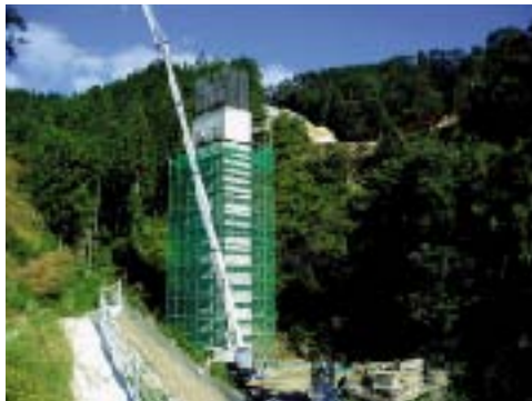
《そば谷橋施工中》
