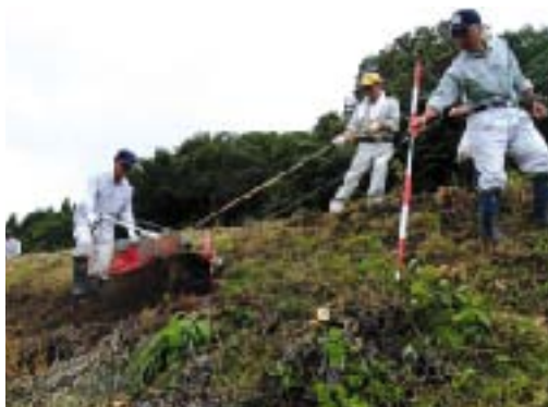
写真3 小段造成風景
