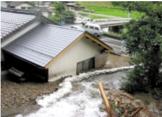
日野町金持地内の被災箇所
