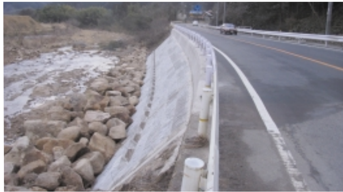
復旧した国道180号日野町福長地区
