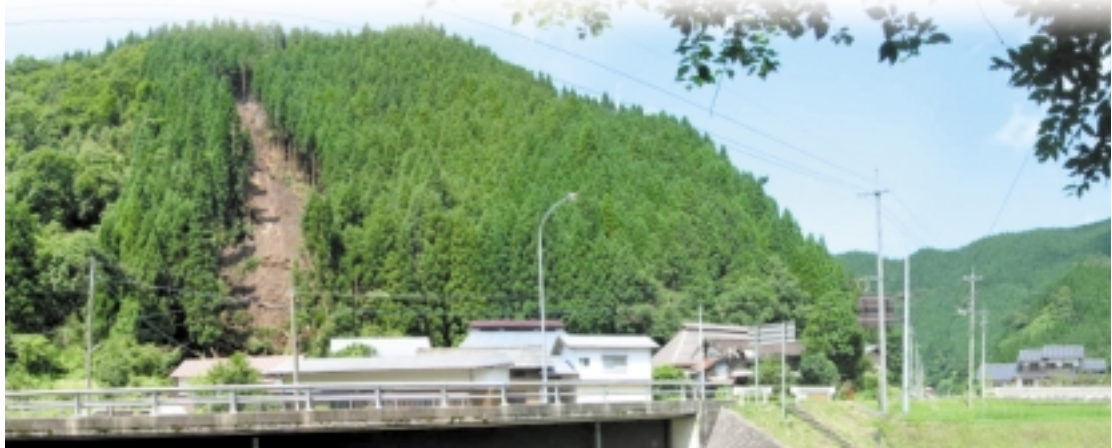
日南町霞地内の被災箇所
