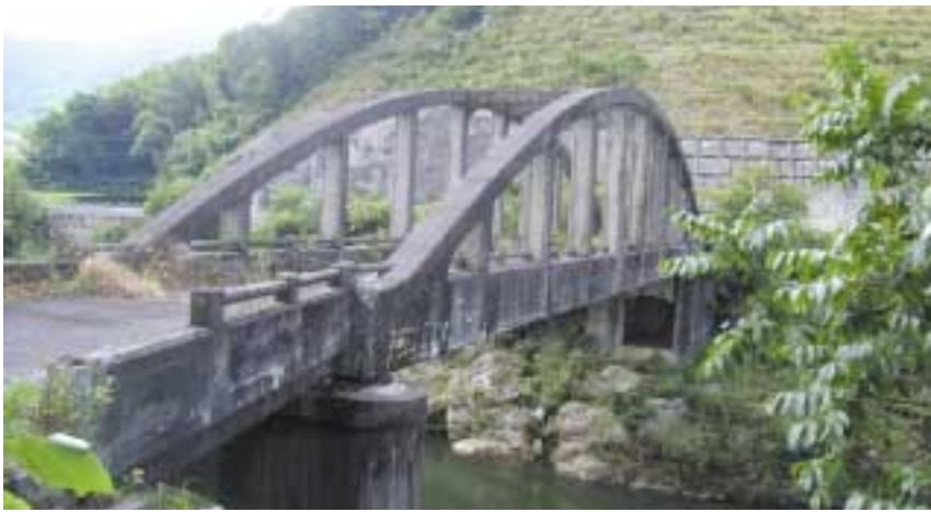
日野川右岸 国道180号側より撮影
