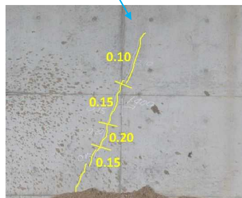
前面側のひび割れ発生状況
