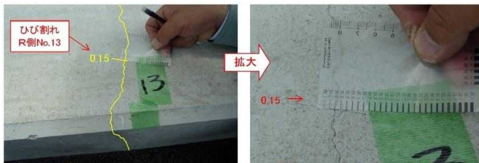
ひび割れ発生状況
