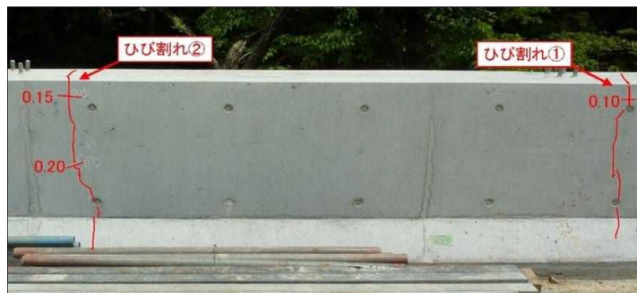
ひび割れ発生状況
