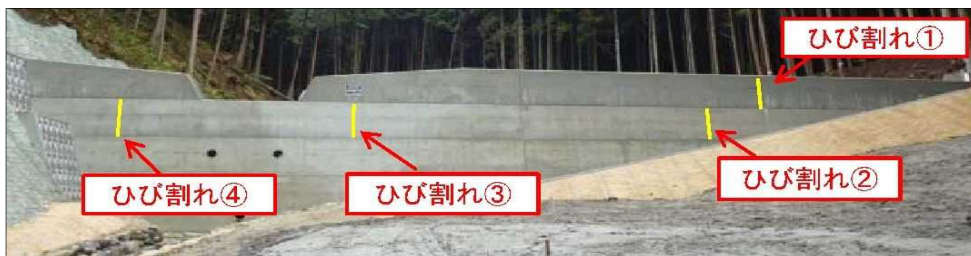
ひび割れ発生状況
