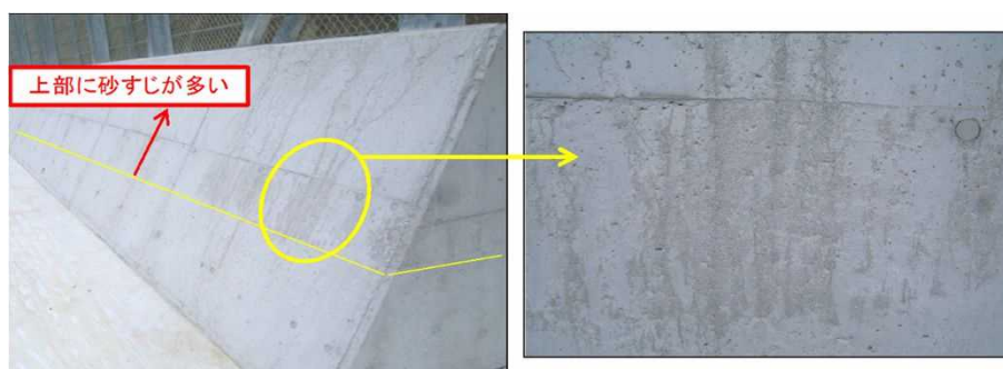
砂すじ ひび割れ発生箇所
