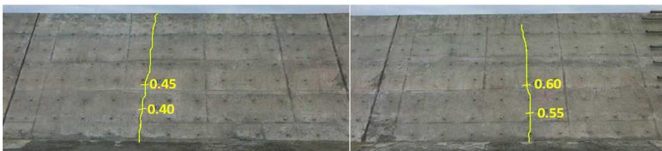
⑤ブロックひび割れ発生状況（伸縮目地間7.5m→この後3.75m間隔としたところひび割れの発生は無かった）
