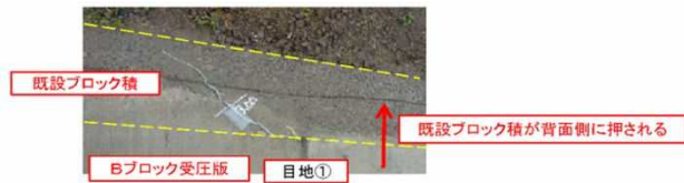
ひび割れ③
