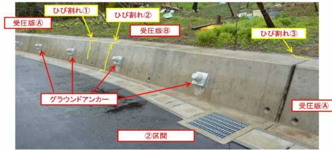
ひび割れ発生箇所
