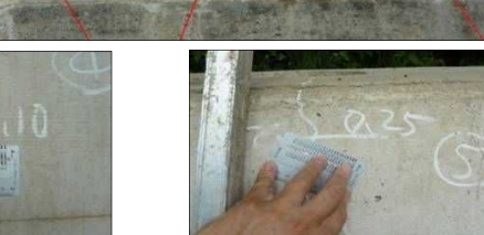
ひび割れ発生状況(4・5)
