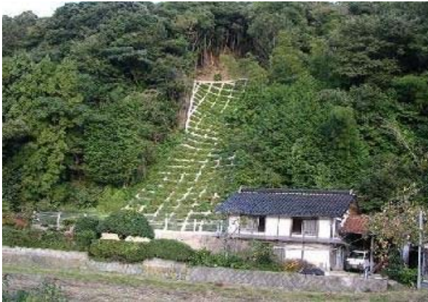
完成 平成20年8月11日
