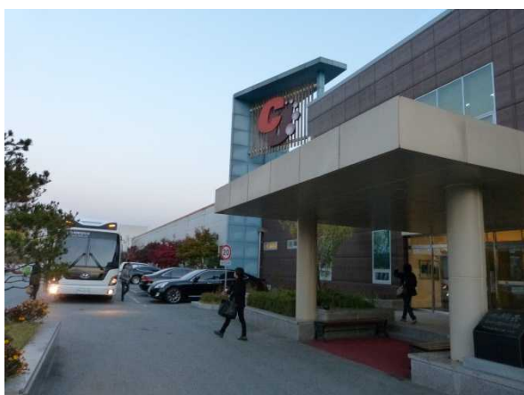
CUメディカルシステムの外観
