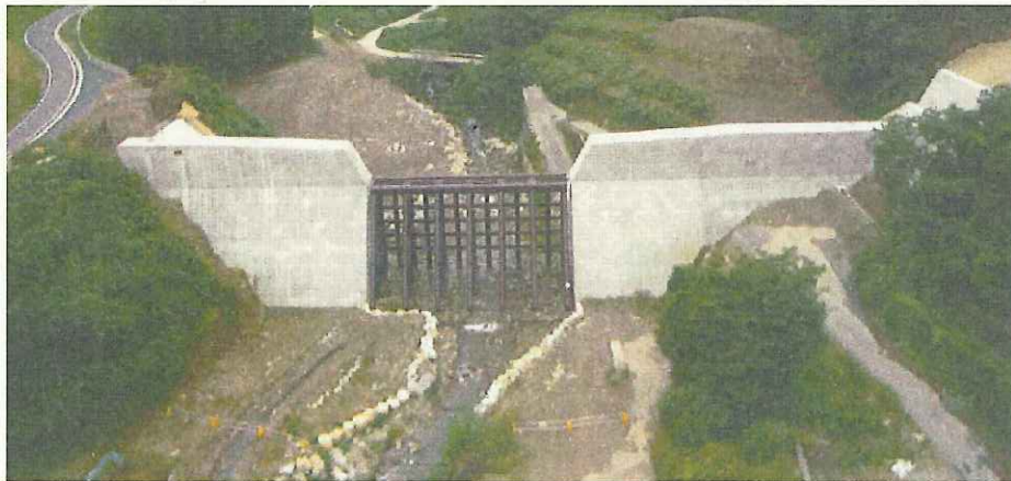
小泉2号砂防堰堤
