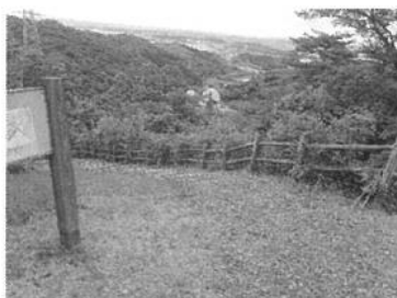
・3階展望台周辺 樹木伐採、剪定作業
