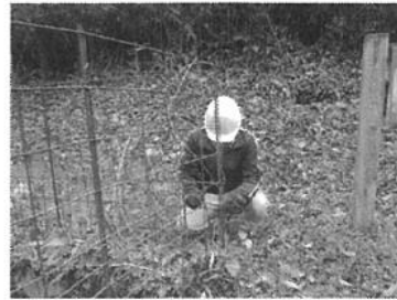
・イノシシ柵補修作業
