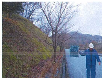
市道沿いサクラ支障枝除去作業
