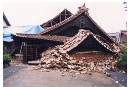
写真2 地震により倒壊した家屋(境港市)
