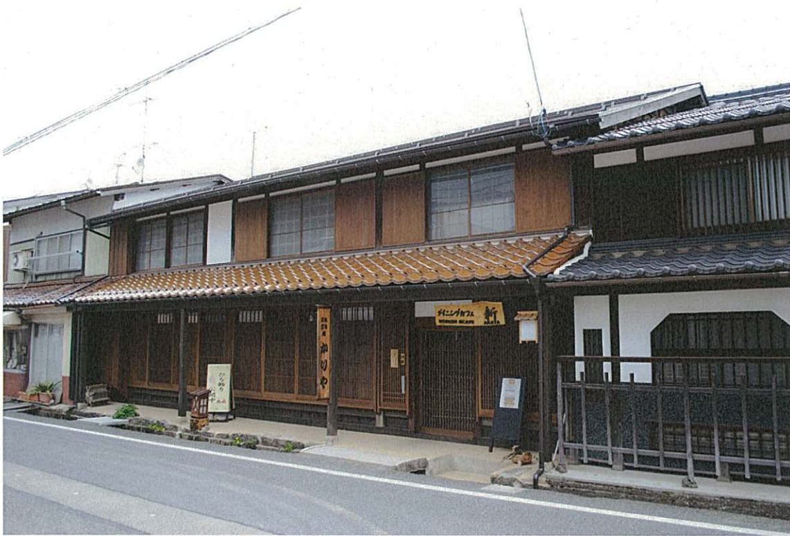
木島家住宅主屋 外観【写真①】
