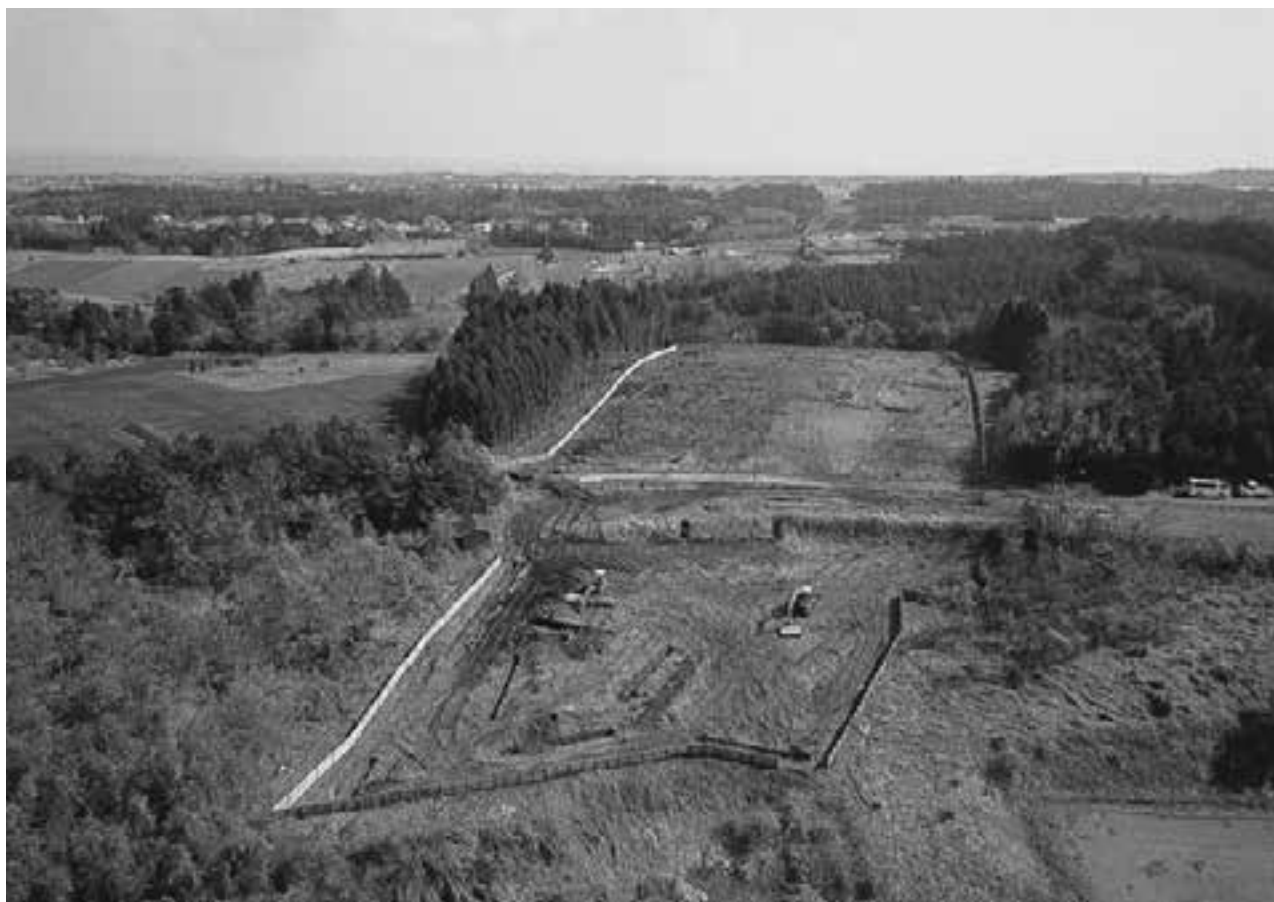
1 調査地周辺の地形(西から)
