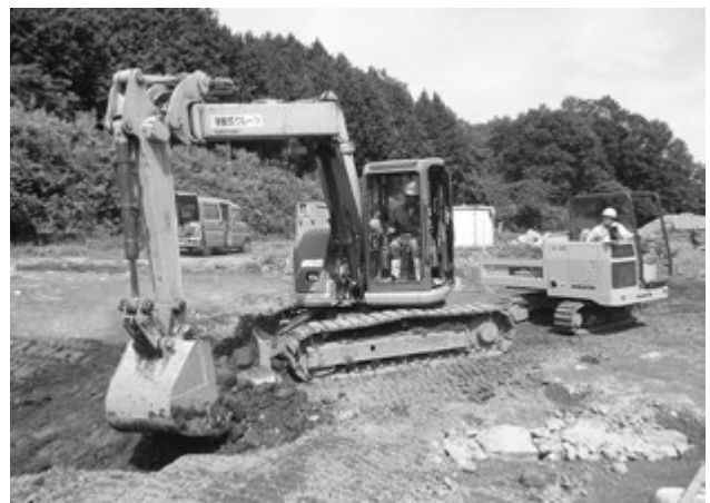
文中写真6 B区暗渠石材除去作業風景
