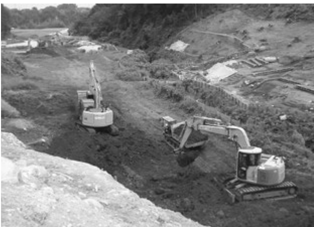
文中写真5 B区重機表土剥ぎ風景
