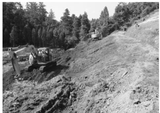
写真4 C区下段重機表土剥ぎ風景
