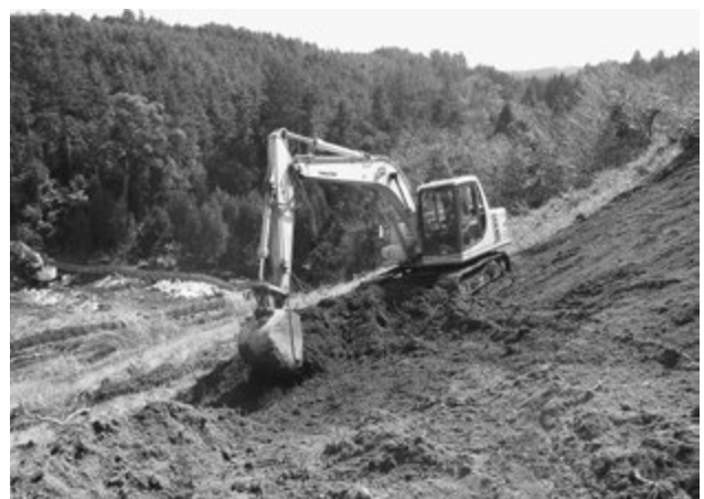
文中写真2 C区上段重機表土剥ぎ作業風景
