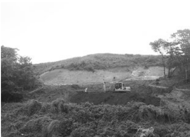
写真3 C区中段重機表土剥ぎ風景
