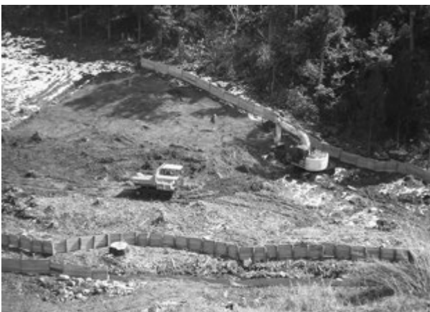
文中写真1 A区重機表土剥ぎ作業風景
